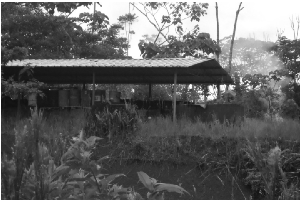
Foto tomada desde la finca del vecino en la que se aprecia el depósito en tanques, al parecer de sustancias tóxicas y de una hoguera al fondo, confirmando la denuncia de los campesinos. En el espacio desde donde se tomó la foto hasta el depósito de la imagen refieren haberse depositado desechos de sustancias quemadas en saquillos tapados sólo con una geomembrana, y otra parte enterrados.
